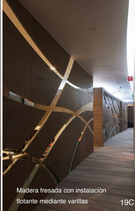
Madera fresada con instalación flotante mediante varillas
